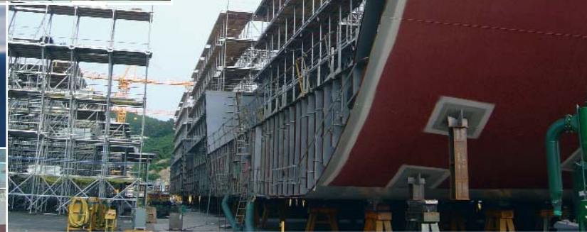
Der Rumpf wird in Segmenten gebaut und bei Kiellegung zusammengesetzt.
